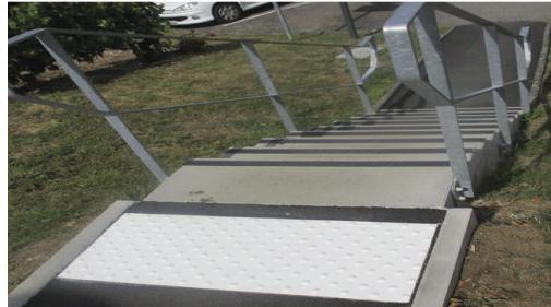
La bande d'éveil de vigilance podotactile WACCESS® se positionne avant et parallèlement à une zone à risque (escalier, vide, traversée dangereuse, passage pour piétons, quai de métro...) pour alerter du danger de chute toute personne s'en approchant.
