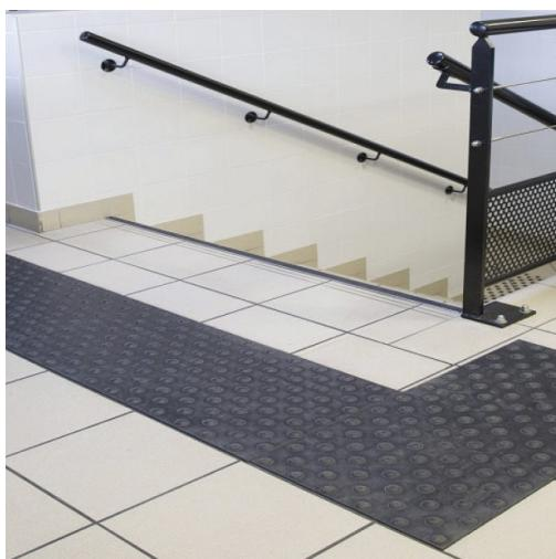
La bande d'éveil de vigilance podotactile WACCESS® se positionne avant et parallèlement à une zone à risque (escalier, vide, traversée dangereuse, passage pour piétons, quai de métro...) pour alerter du danger de chute toute personne s'en approchant. Leur géométrie en 3D permet la détection du danger par le pied.
